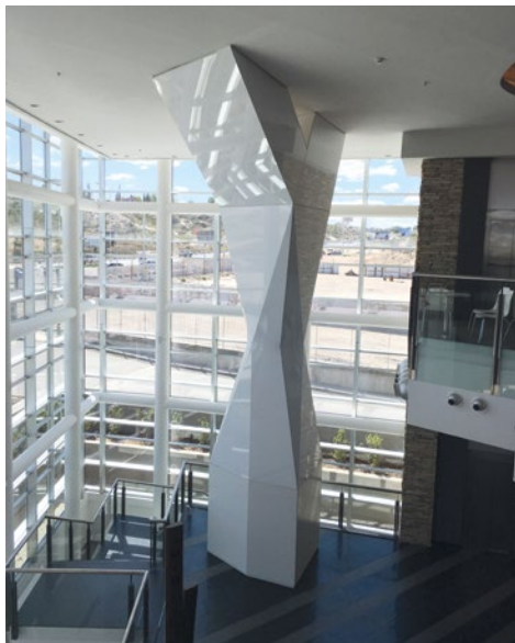
Réalisation : WAGG S.A.
