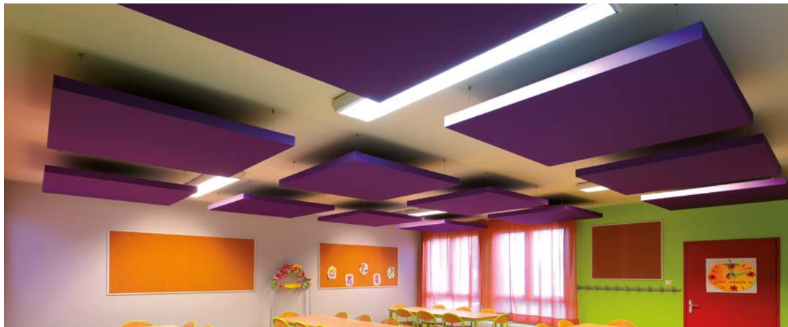
Arch. : SPC acoustique
